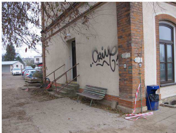
Foto č.6 – pohled na západní fasádu bez výraznějších znaků projevů vztlínající zemní vlhkosti
