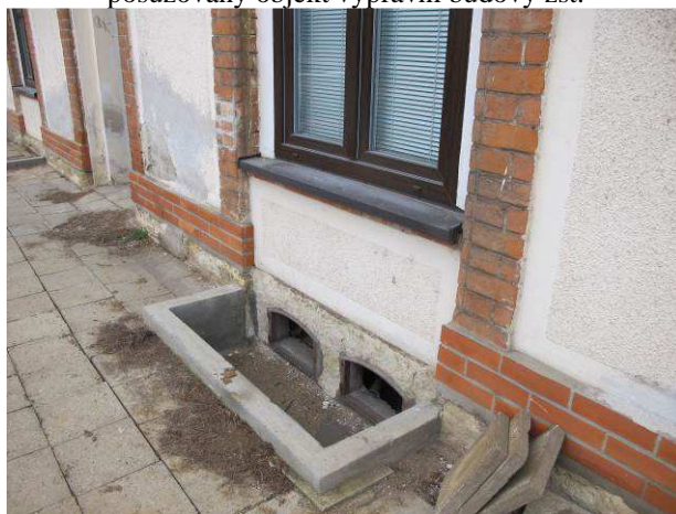
Foto č.4 – pohled na anglický dvorek ze strany kolejiště, projevy vlhkosti na omítkách mezi okny a ve spodní úrovni ve špaletách dveří a nad soklem
