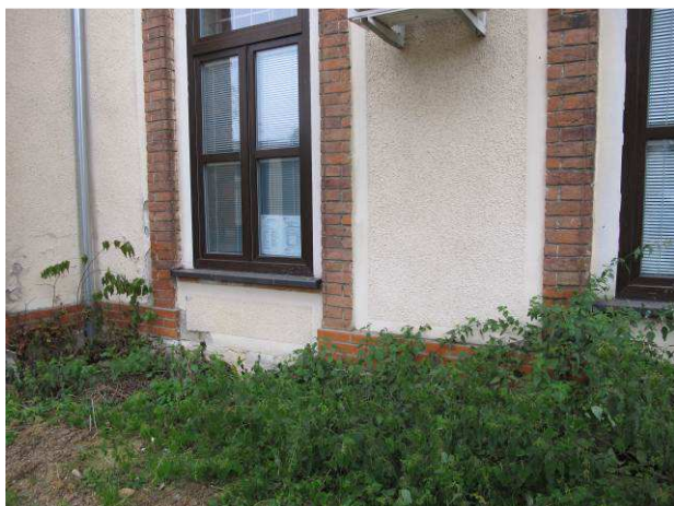
Foto č.7 – pohled na část severní fasády s charakterem přilehlé plochy a vlhkostními projevy na omítkách ve spodní úrovni
