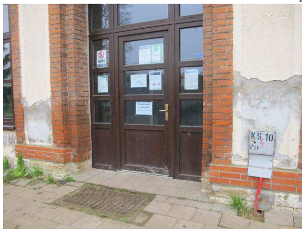
Foto č.8 – pohled na hlavní vstup do výpravní budovy s projevy vlhkosti na obou stranách
