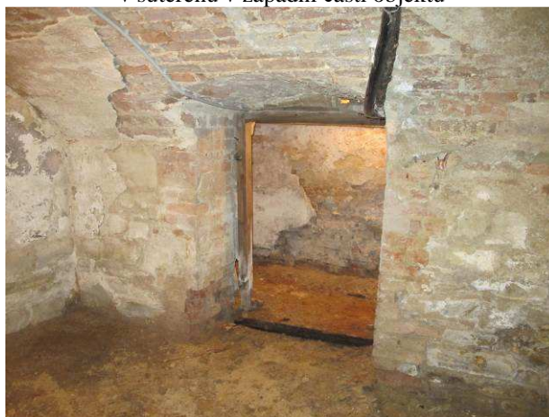
Foto č.12 – destrukce omítek, povrchu cihelného zdiva a tlející dřevěné prvky zárubní vlivem zemní vlhkosti a vysoké vnitřní relativní vlhkosti
