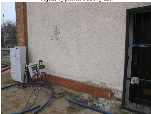
Foto č.3 – pohled na část východní fasády s projevy vlhkosti nad kabřincovým soklem
