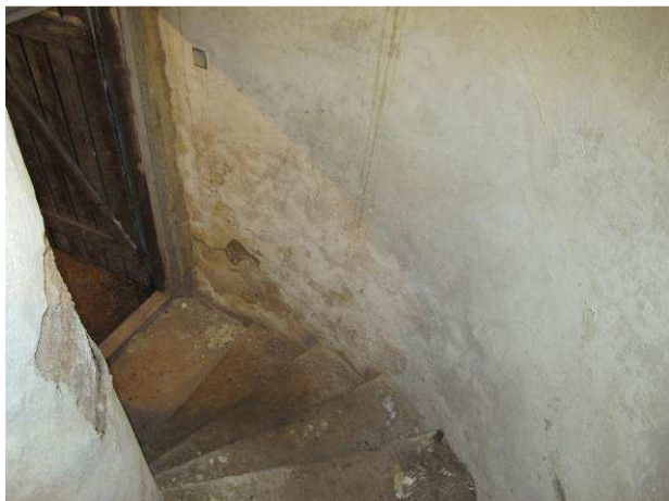
Foto č.13 – pohled na vstupní schodiště do suterénu ve východní části objektu s viditelnými projevy vlhkosti na povrchových úpravách
