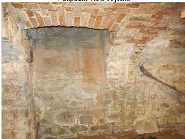
Foto č.11 – charakter obvodového a vnitřního zdiva v západní části suterénu
